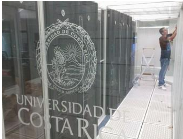
Fig. 3. Vista del pasillo frío durante la instalación. (Fuente: Centro de Informática UCR 2013)
