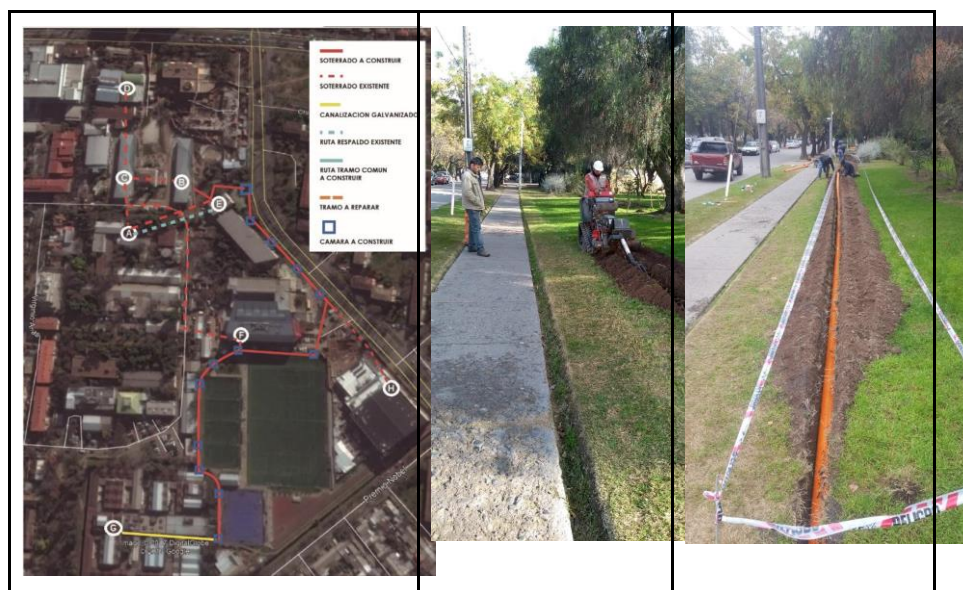
Figura 5. Tramos a construir en campus Juan Gómez Millas. Máquina zanjadora y canalización final.
